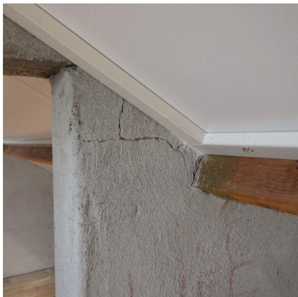
Foto 02: Zolderverdieping; De onderzijde van het dak is voorzien van een isolatiebeplating. Plaatselijk zijn enkele lichte scheuren zichtbaar in het metselwerk.
